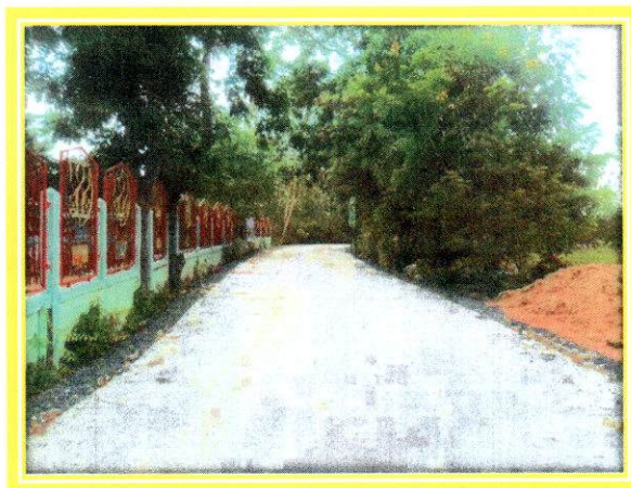
โครงการก่อสร้างถนนคอนกรีตเสริมเหล็ก บ้านกะพี้ หมู่ที่ ๖ สายหน้าบ้านนางอุราชา อดสันเทียะ ถึงวัดกะพี้
